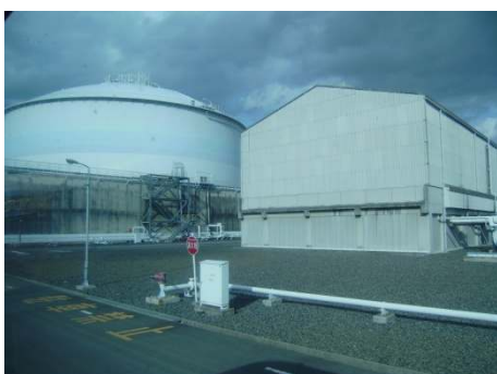
LNG貯蔵タンク
